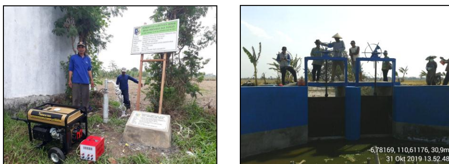
Gambar 3.5 Pembangunan Irigasi Air Tanah dan Dam Parit
